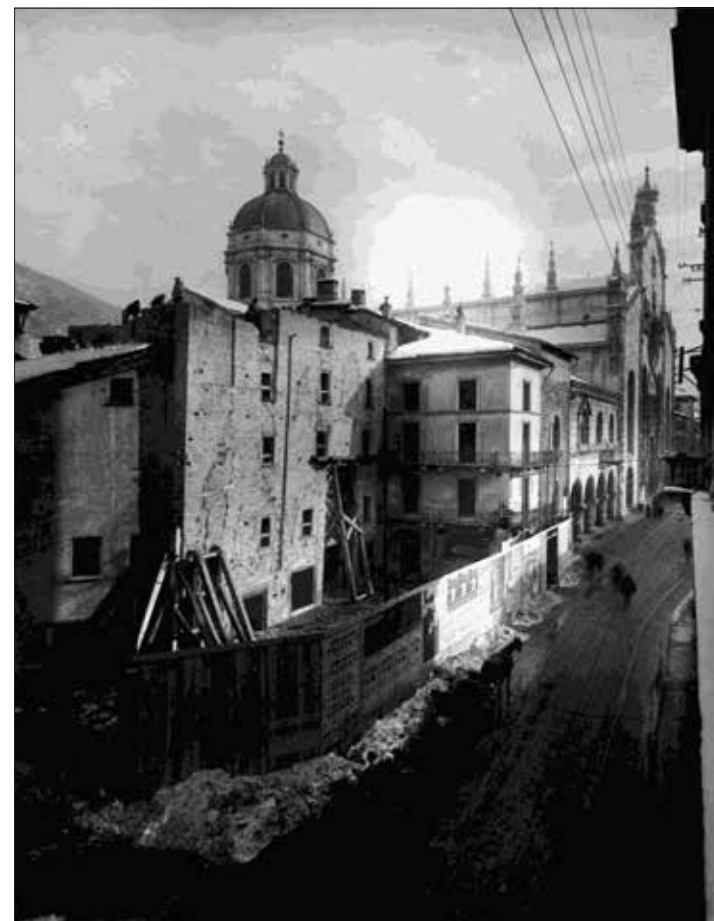
Lavori di demolizione dei fabbricati addossati alla torre del Broletto (1924-1925). La torre sarà ricostruita nel 1927 a cura dell'architetto Frigerio. Nella pagina accanto, alcuni reperti medioevali del quartiere Cortesella sopravvissuti alla demolizione. (F. Cani e D. Pandakovic, Il Duomo di Como nelle fotografie di Federico Frigerio e Riccardo Piatti , Alessandro Dominioni ed., Como 2004).
