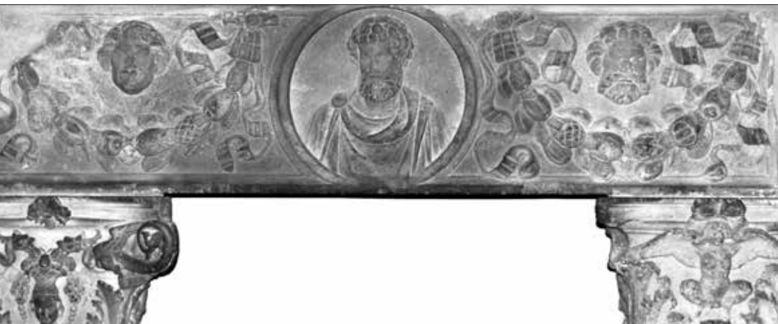
La struttura massiccia e compatta del camino nella composizione che appare oggi, con gli elementi in pietra decorati.
