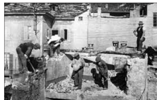
Lavori di demolizione del quartiere Cortesella di Como, negli anni Trenta. (G. Ciucci [a cura di], Giuseppe Terragni 1904-1943 , Electa, Milano 1996).
